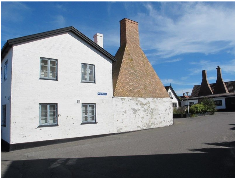
III. 7 Aarsdales karakteristiske lidt brede røgeriskorstene med skorstenspiber i blank mur.
