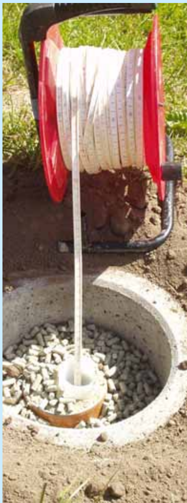
Overvågningsboring hvor der pejles
