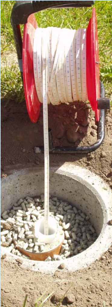
Overvågningsboring hvor der pejles
