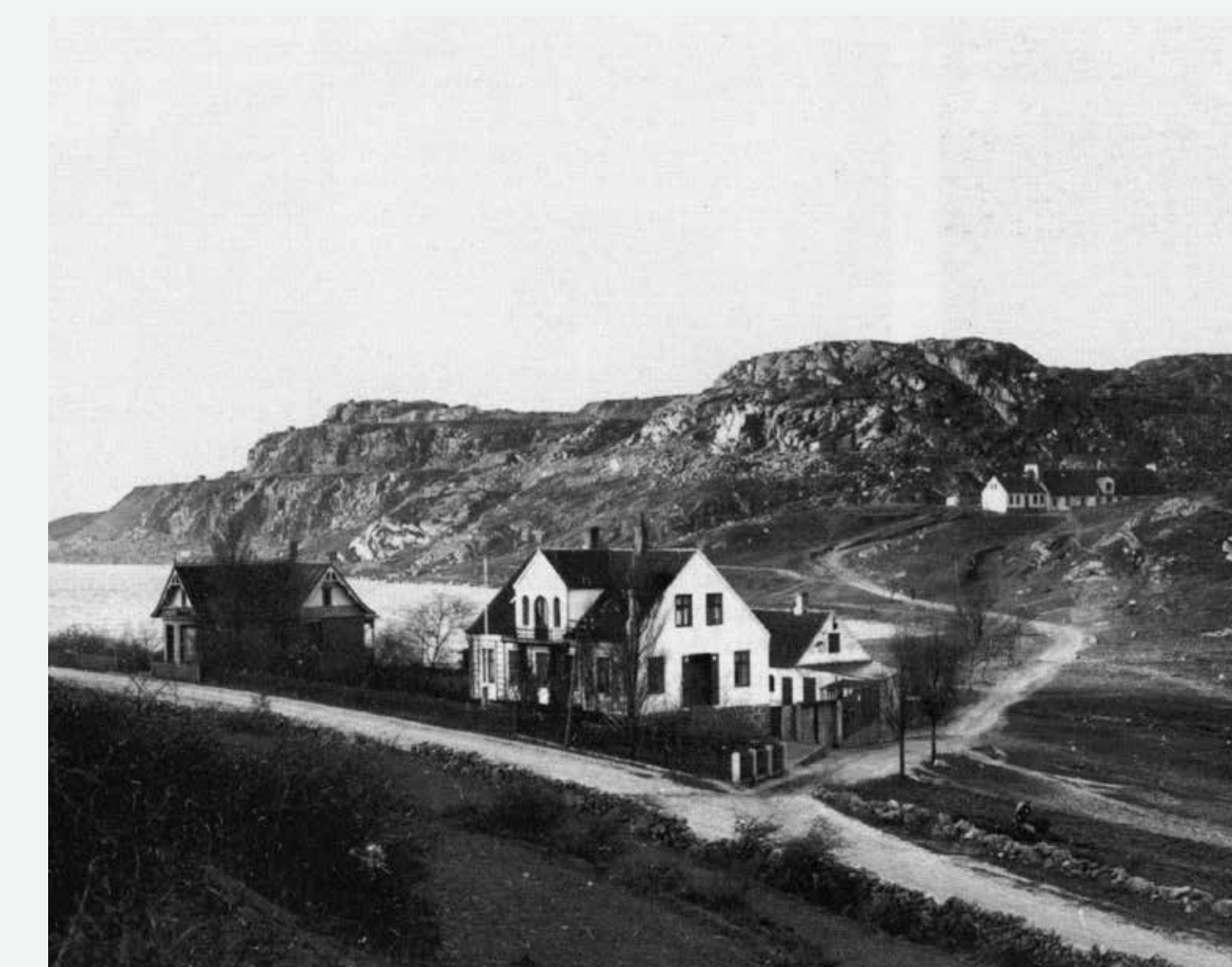
Stenværksbestyrer A.R. Wibergs bolig fra 1887 og Humledal i baggrunden. Til venstre, terrakottafabrikant L. Hjorths ejendom.
