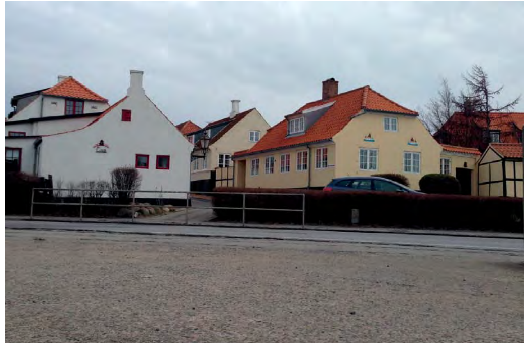
E: Her ses adgang til vandet ved Nørrekåsgade/Silkegade.
