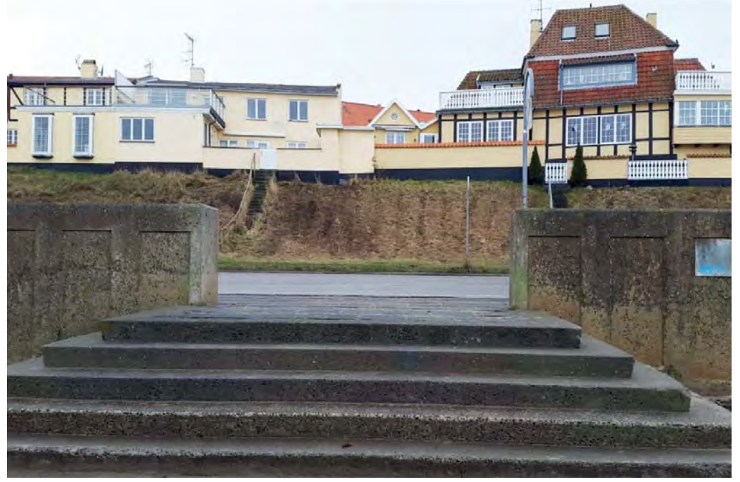
D: Billedet viser, hvor der på sigt kan etableres en ny fodgængerforbindelse fra byen til stranden. Et eksisterende privat udhus, som er bygget midt i det offentligt ejede gænge mellem Storegade og skråningen, skal dog først fjernes.
