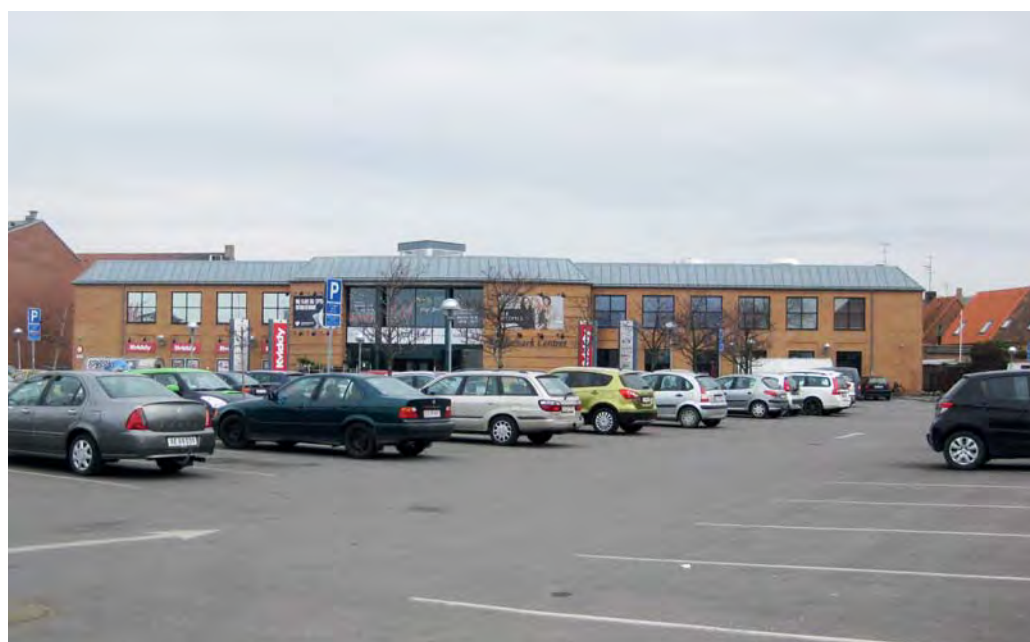
Billedet viser parkeringsarealet foran Snellemark Centret. De samlede parkeringsområder ud for Hoffmann, Snellemark Centret og Rønne H bør indrettes mere effektivt. Derudover bør det indrettes, så det gøres mere spændende og imødekomende. Det kan bl.a. gøres ved at synliggøre stiforbindelserne. Dette vil medvirke til at opnå et andet hierarki fodgængere og bilister imellem, hvor fodgængere vil blive prioriteret højere end i dag.
