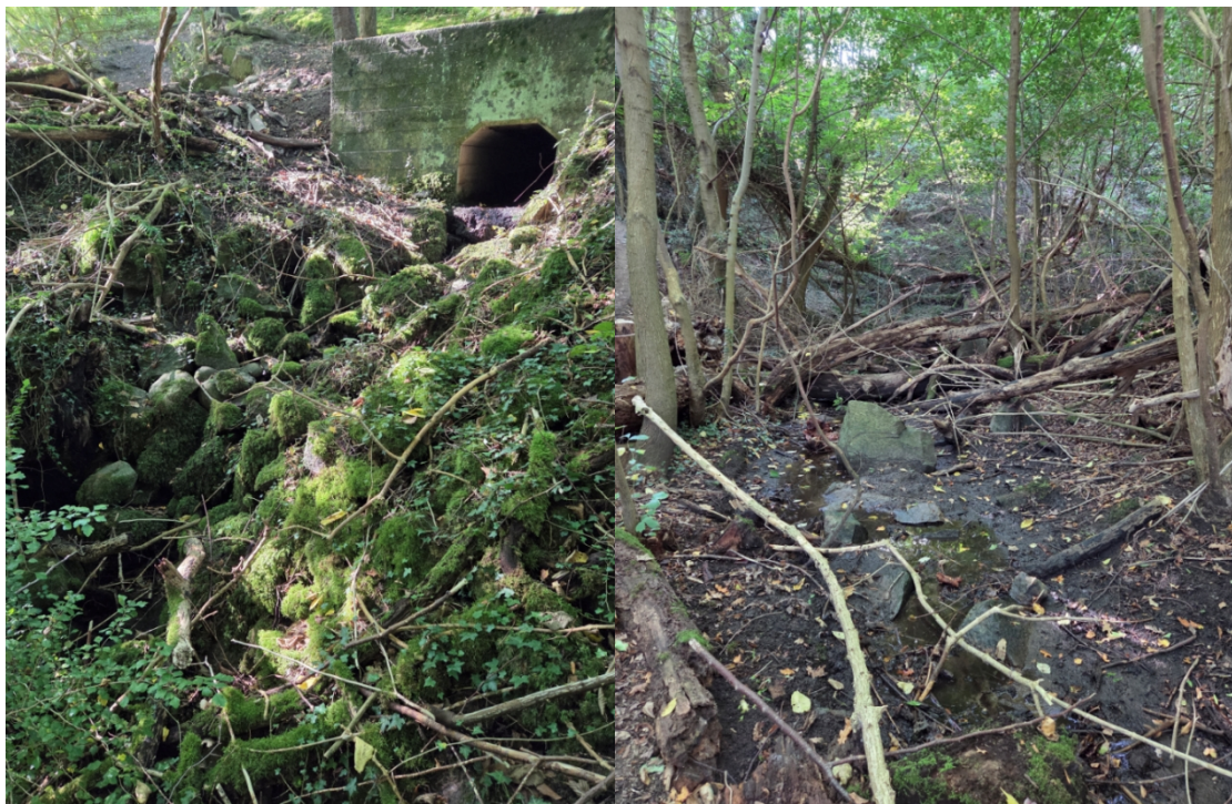
Figur 5 og 6 – Højre: viser udløb i nordlige del af røret. Venstre: viser sten og træmateriale i vandløb. Kilde: BRK.
