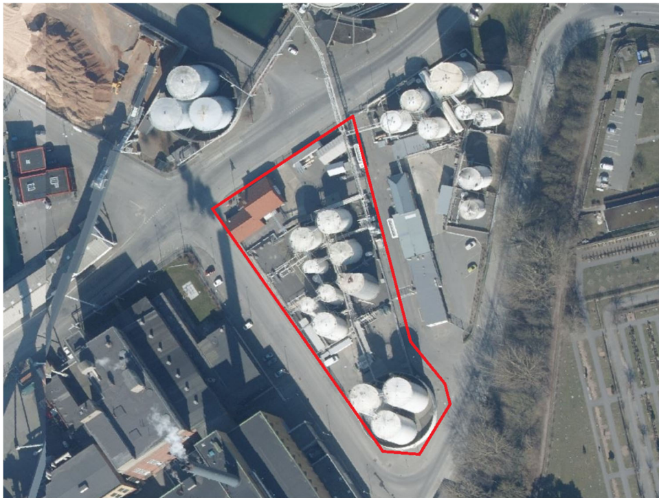
Figur 1. Depotet med tilhørende tanke og installationer.
