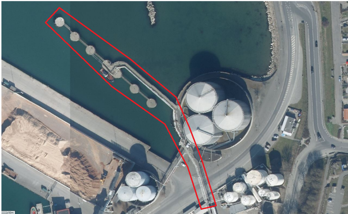
Figur 2. Pieren samt tilhørende rørføring over Munch Petersens Vej.
