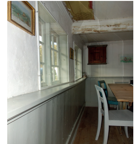
III.7. I bygninger med lille rumdybde kan en vægisolering op til vindueskarme være et godt kompromis.
