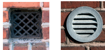
III.6. Ventilationsriste kan medvirke til at sikre en naturlig udluftning.
